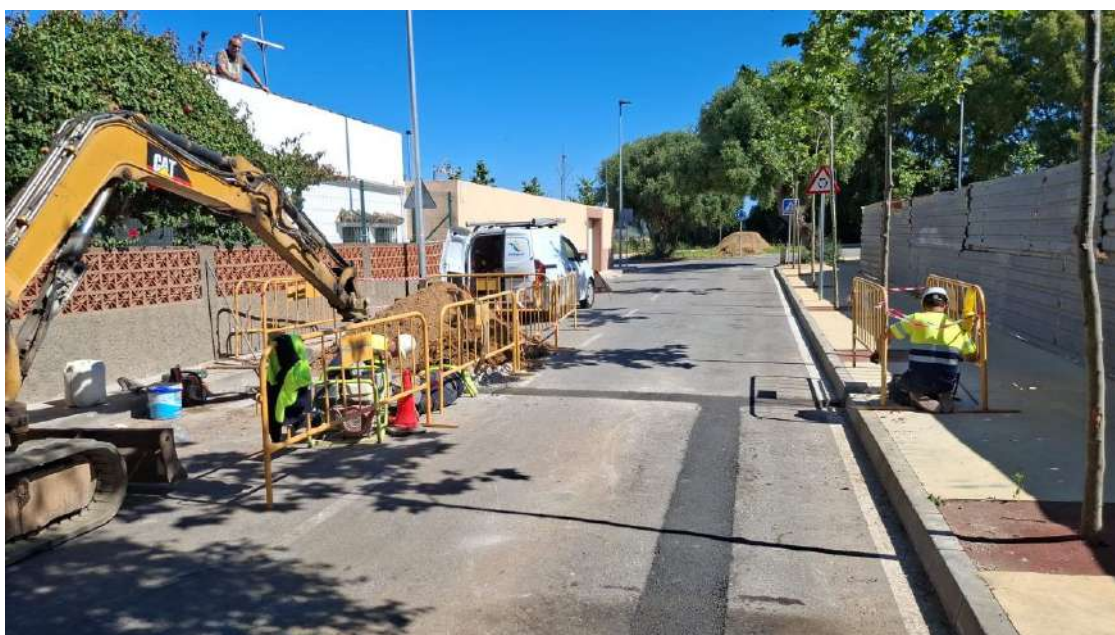
Obras de renovación de la red de agua en la avenida Embarcadero, en Algeciras. / Ayuntamiento de Algeciras
