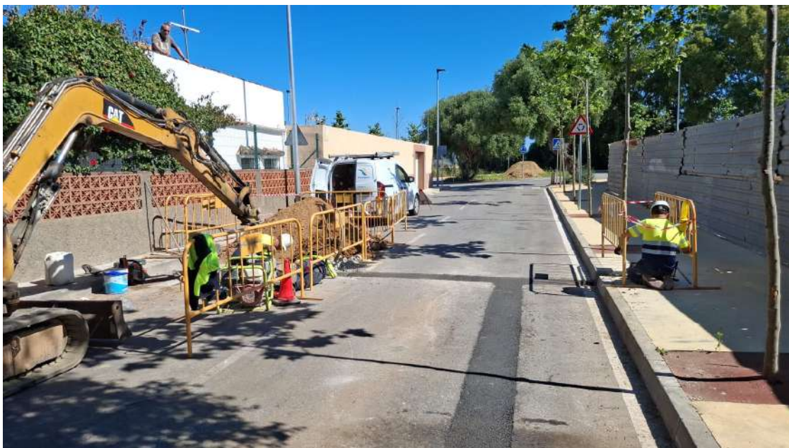
Finaliza la obra de renovación de la red de abastecimiento en la avenida del Embarcadero.
