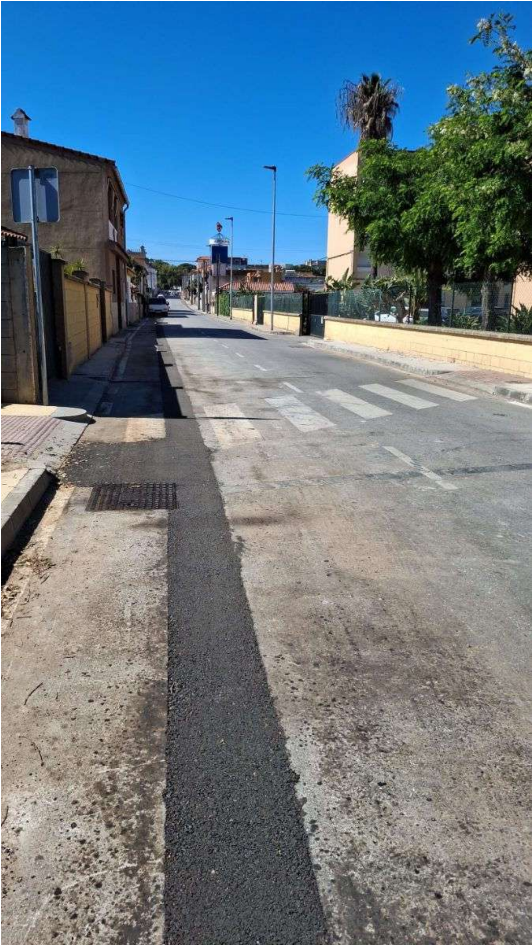
avenida embarcadero - Fin a la primera fase de renovación de la red de agua en el
