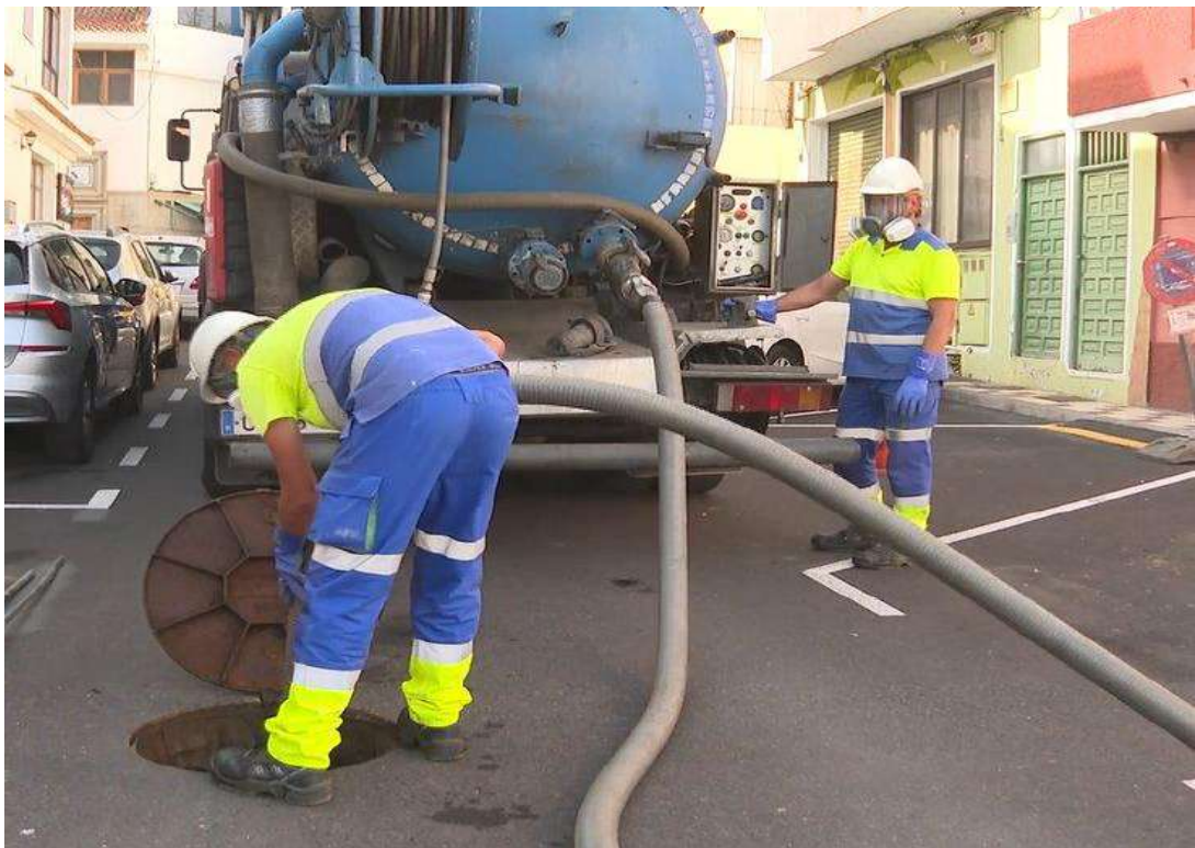
La limpieza se ha centrado en el alcantarillado del barrio de Punta Brava. RTVC.
