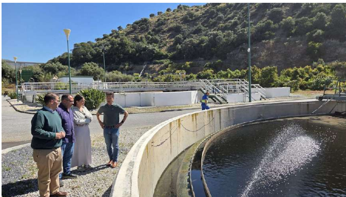
Visita a la EDAR de La Herradura (MANCOMUNIDAD)
