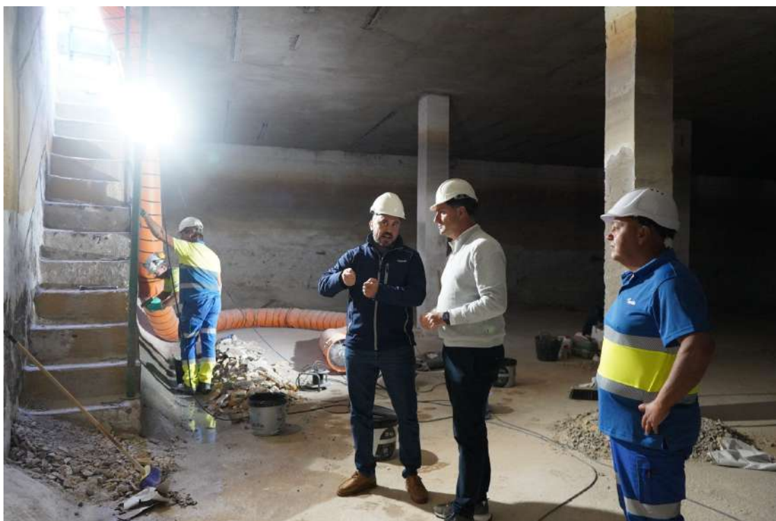
El alcalde durante la visita a las obras
